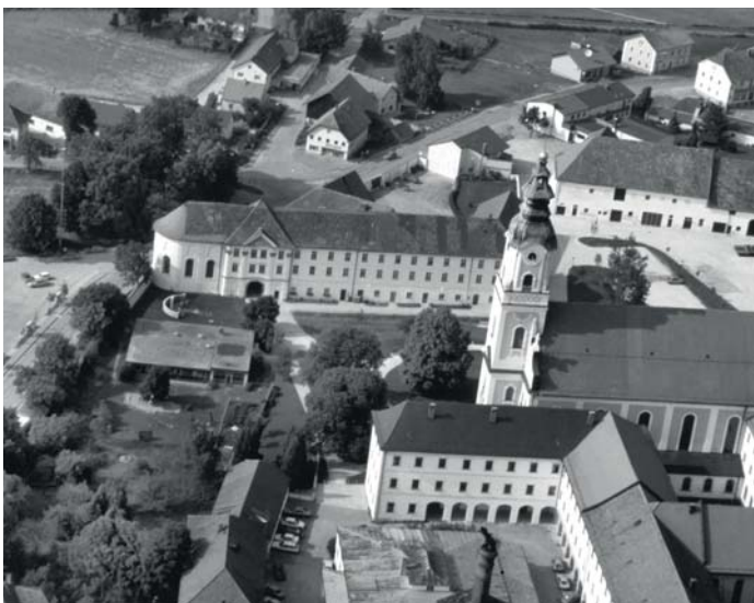
Situation zu Beginn der Sanierung – etwa 1990
