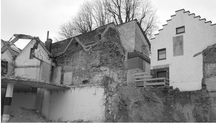
Ansicht Bereich Stadtmauer von Norden
