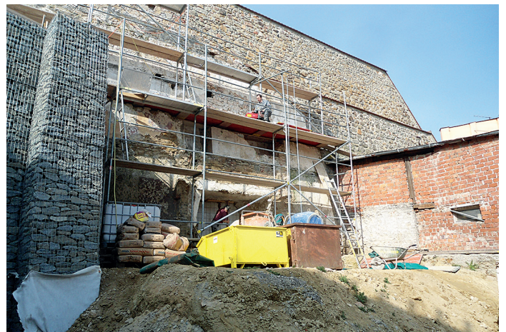
Sanierung historische Stadtmauer
