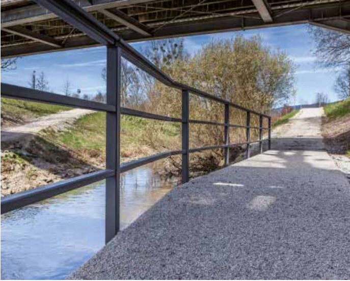
Die neu gestalteten Unterführungsstege am Bogenbach
