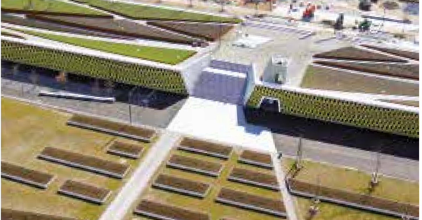
Die große Freitreppe markiert den Übergang in die Parklandschaft an der Donau
