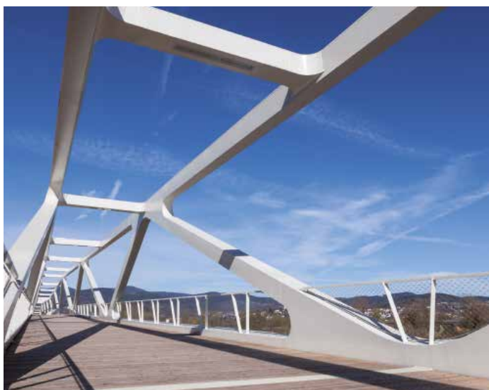
Die neue Geh- und Radwegebrücke über die Donau
