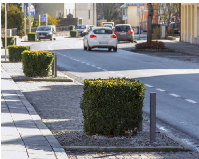
Die neu gestaltete Bahnhofstraße
