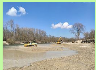
Kieseinbringung an der Unteren Isar bei Landau (Foto: WWA Landshut)
