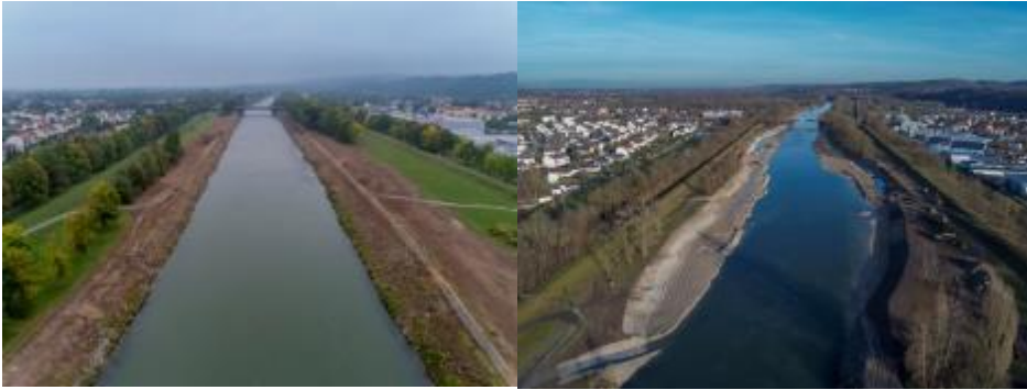
Naturferner, kanalartiger Abschnitt der Dingolfinger Isar vor (links) und nach Beginn der Renaturierung (rechts). Fotos: Regierung von Niederbayern
