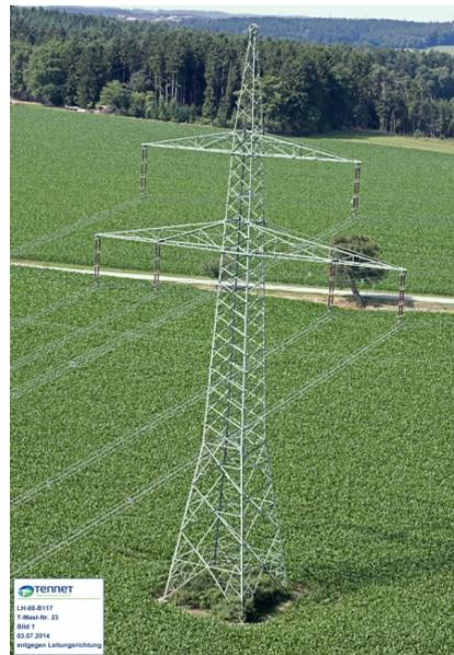
**Abbildung 17: 380-kV-Stahlgitter-Mast Nr. 23 der 380-kV-Ltg. Isar – Pleinting (B117)**
