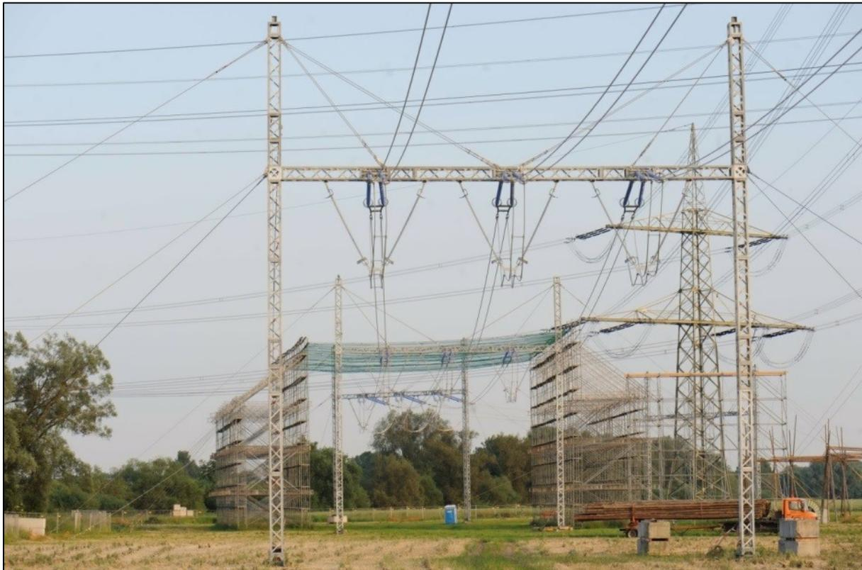
**Abbildung 14: 380-kV-Freileitungsprovisorium für ein System mit errichtetem Schutzgerüst im Bereich einer Höchstspannungsquerung**
