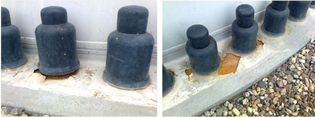
**Abbildung 12: Korrosionsprobleme im Flanschbereich bei Vollwandmasten**
