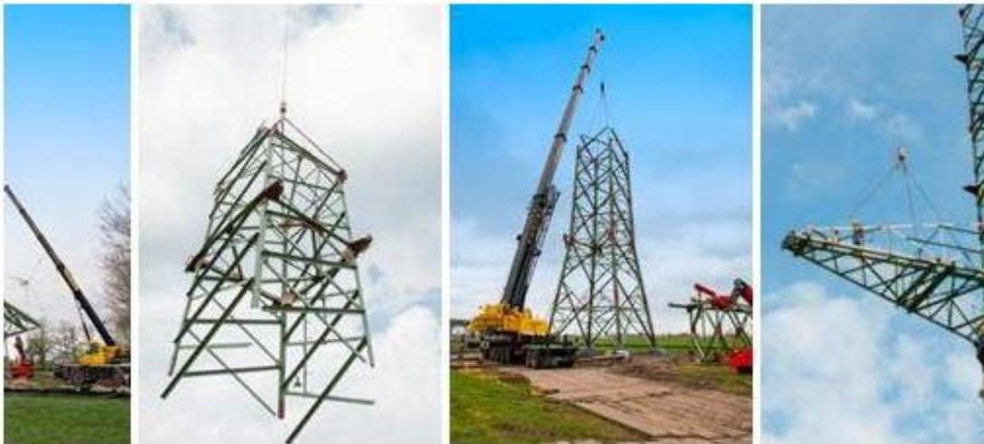
**Abbildung 61: Mastmontage mittels Mobilkran**
