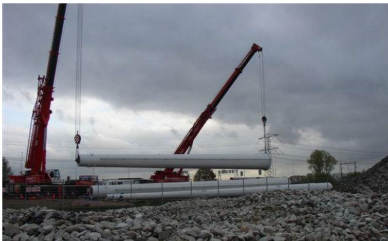
**Abbildung 11: Aufstellen von Vollwandmasten mit Kränen**
