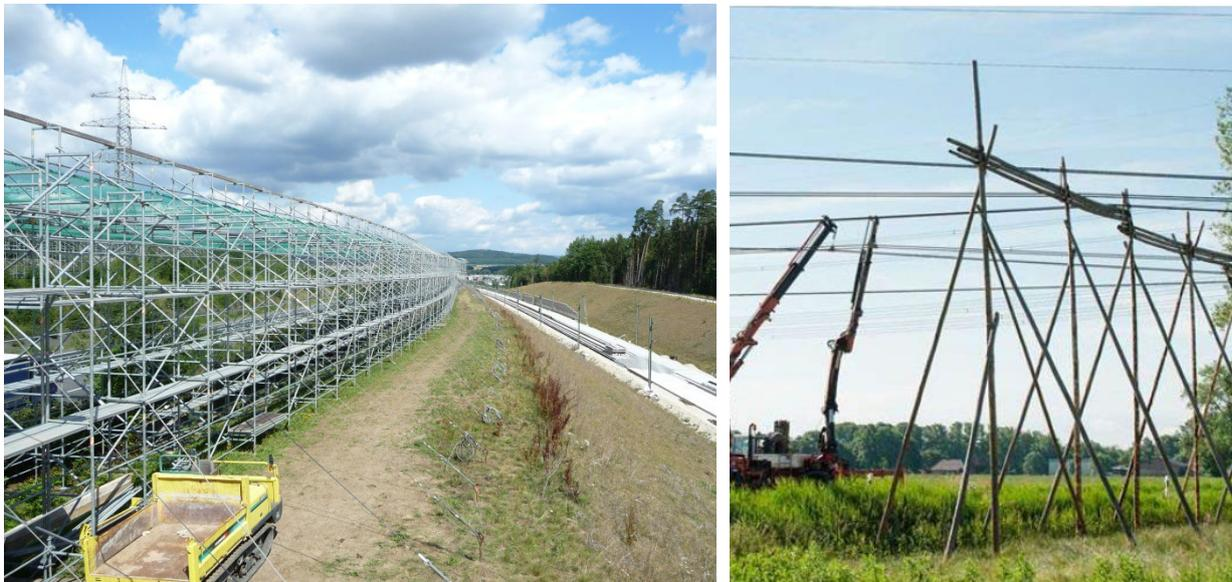
Abbildung 64: Schutzgerüste aus Metall und Holz
