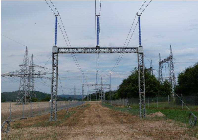
**Abbildung 39: Freileitungsprovisorium für ein System mit Abankering**
