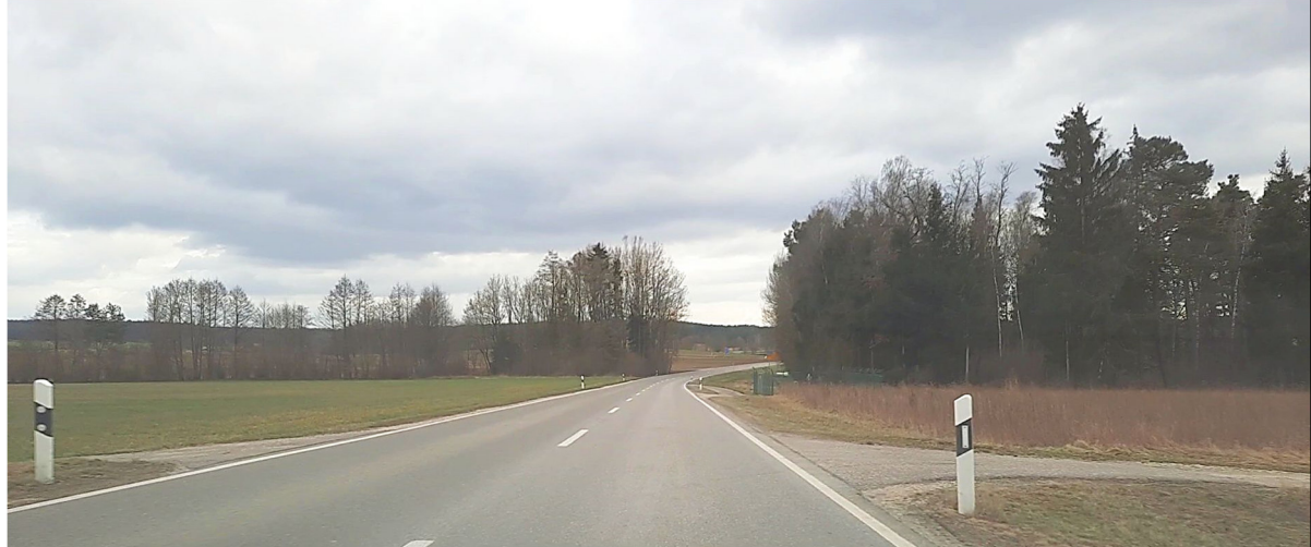
Bild 1: Standort nördlich der Zuwegung auf St2230 mit südlicher Blickrichtung auf vorhandene Zufahrt
