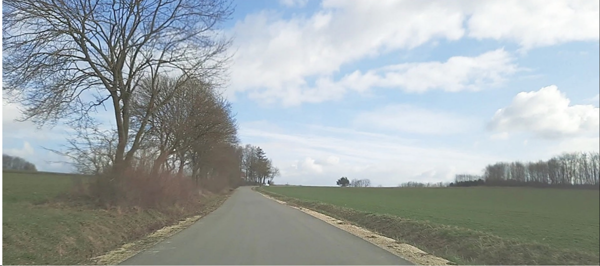
Bild 1: Standort bei Bau-km 0+050 mit südöstlicher Blickrichtung auf Kapellenweg
