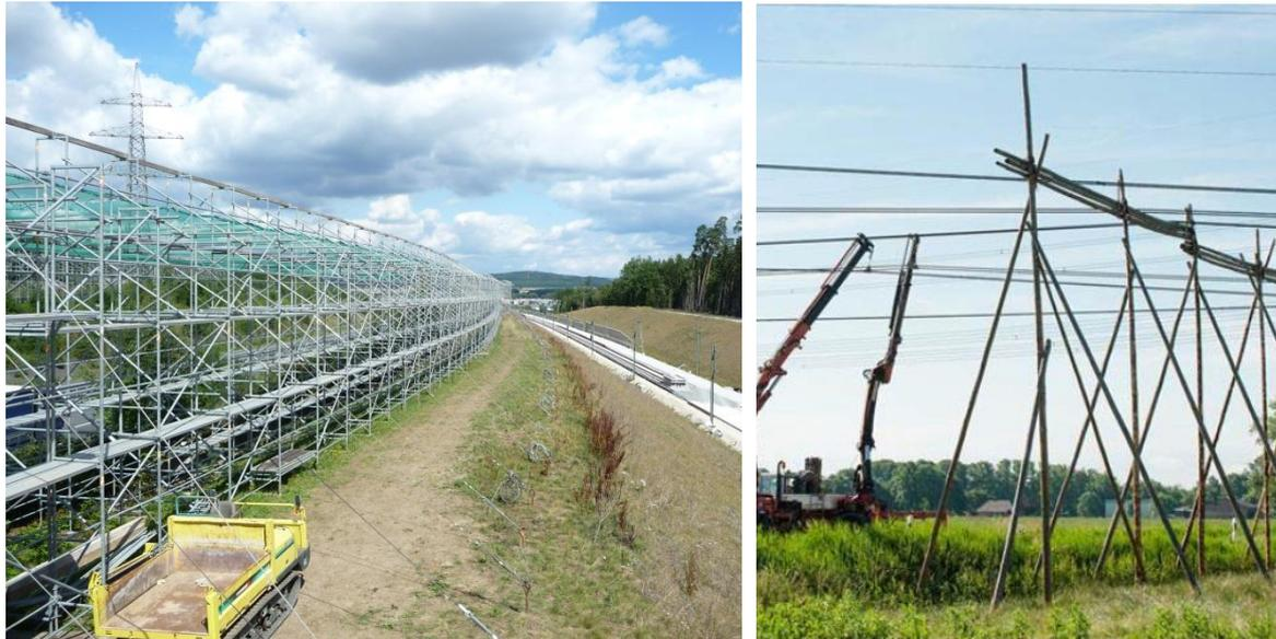
Abbildung 34: Schutzgerüste aus Metall und Holz
