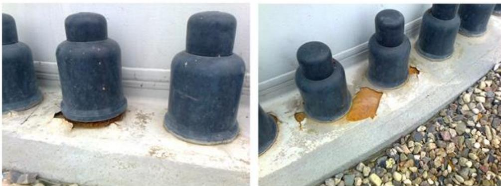
Abbildung 9: Korrosionsprobleme im Flanscbereich bei Vollwandmasten
