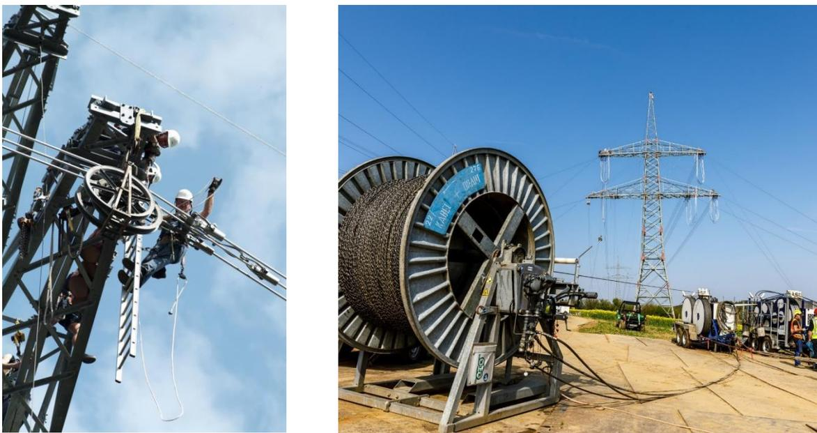
Abbildung 33: Leiterseile liegen während des Seilzugs in den Laufrollen
