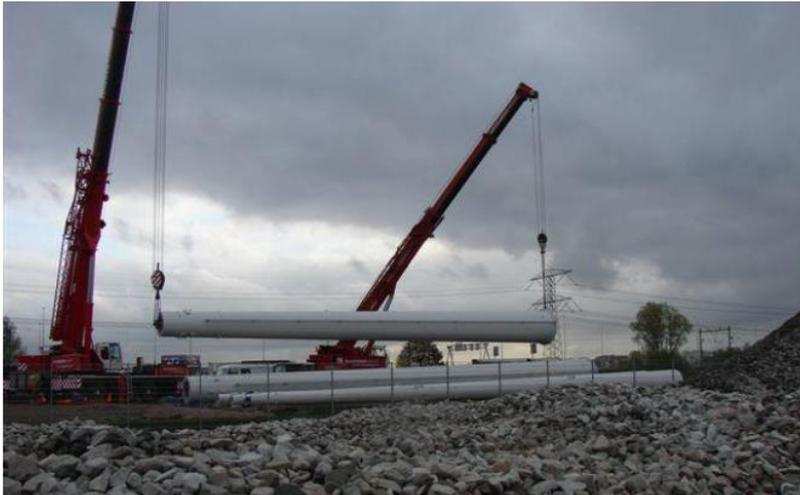
Abbildung 8: Aufstellen von Vollwandmasten mit Kränen
