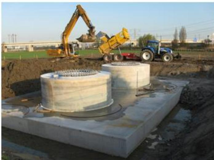
Abbildung 7: Vollwandmast mit zwei Türmen
